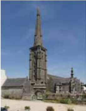
Eglise et son enclos - Vue générale
