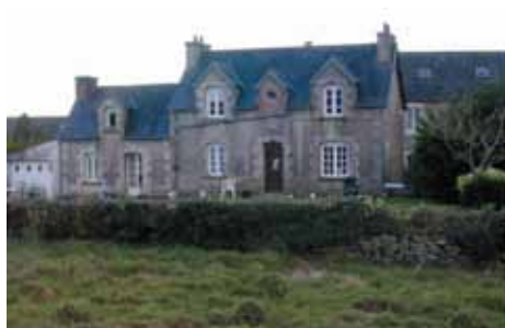
Maison 1920, élévation est, 37, rue de Penquer
