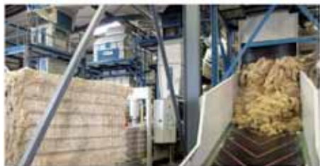
L'usine de transformation de chanvre à Cezères.
