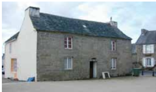
5, place de l'Eglise. Elévation sud-est
