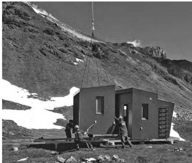
Expérimentation « constructive » avec le Parc de la Vanoise : installation du prototype d'abri de berger TATOU sur l'alpage du Pelvoz (juillet 2018)
