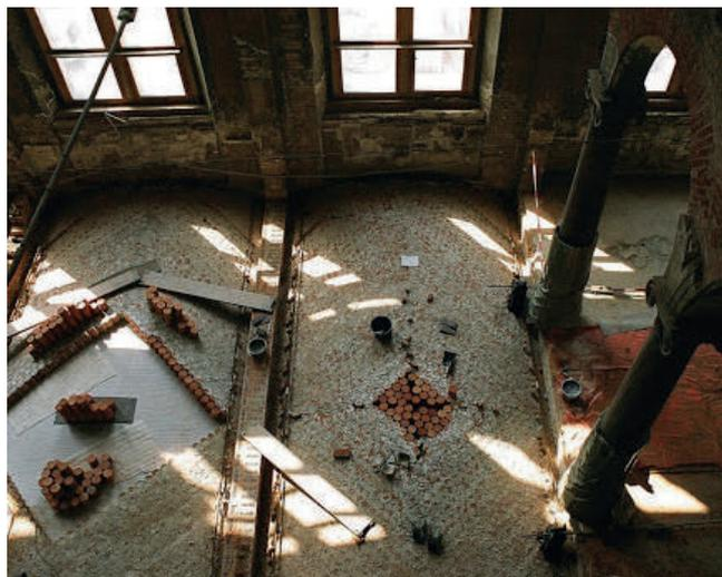
MISE EN OEUVRE DE CYLINDRES D'ARGILE CREUX, SALLE MODERNE
