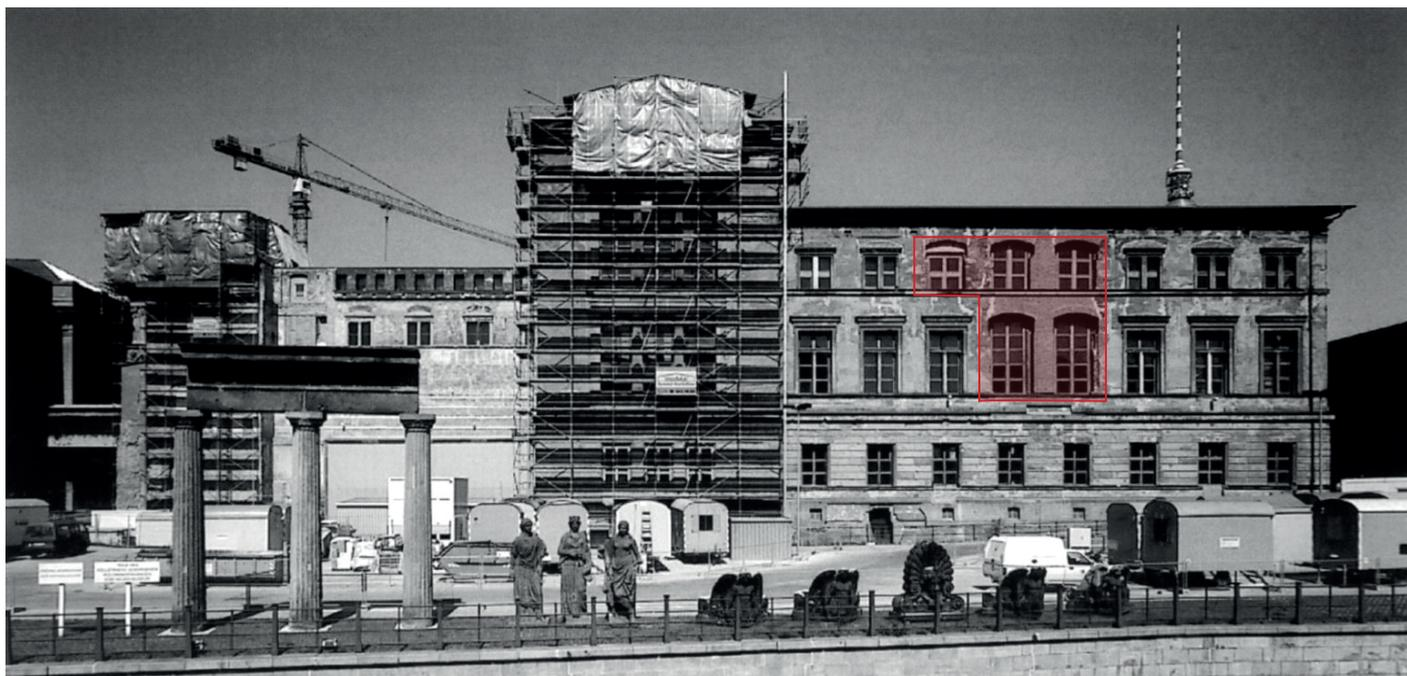
FAÇADE OUEST PENDANT LES TRAVAUX : À DROITE, LES 5 FENÊTRES ENDOMMAGÉES AVE LEUR ARC EN BRIQUE APPARENT.
