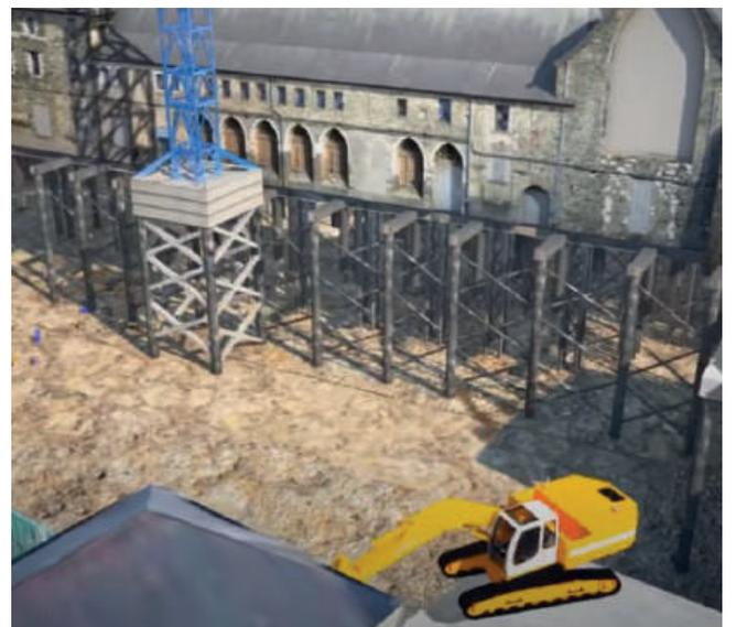
SURÉLÉVATION SUR MICROPIEUX DU COUVET, PHASE CHANTIER
