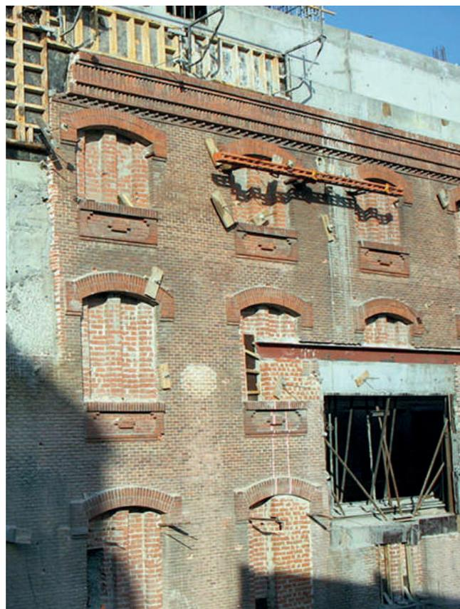
POUTRE MÉTALLIQUE ET LINTEAU BÉTON EN ARRIÈRE PLAN
