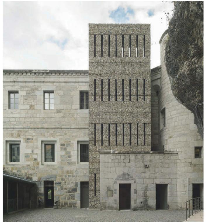
La dernière phase concerne la salle d'exposition qui est située dans un bâti édifié en 1853. Construit en pierre calcaire de la région, ce bâti a un système structural en voûte au rez-de-chaussée, sur lequel le nouveau plancher de la salle d'exposition de 140 m<sup>2</sup> vient reposer. Ce plancher est surélevé au-dessus des voûtes dans le but de préserver et de ne pas fragiliser la structure existante.
