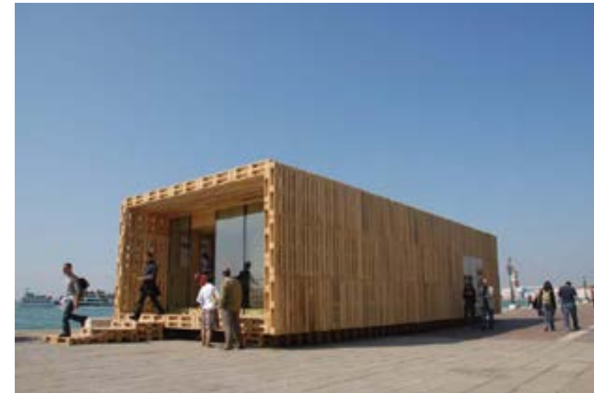
bâtiment en palettes
