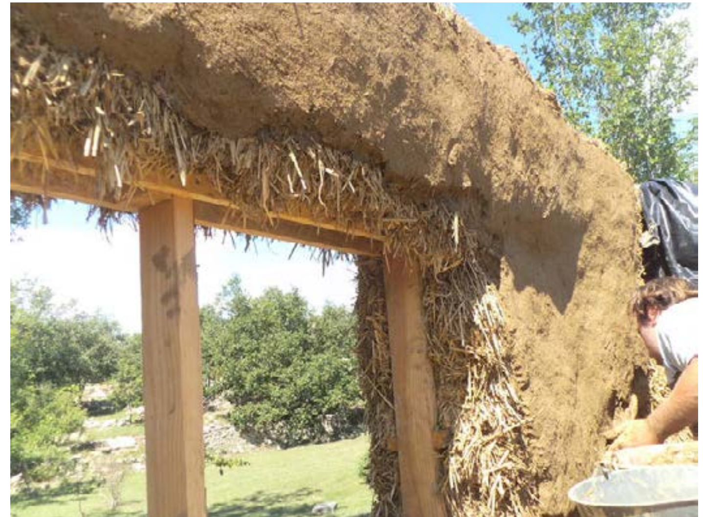
construction en paille
