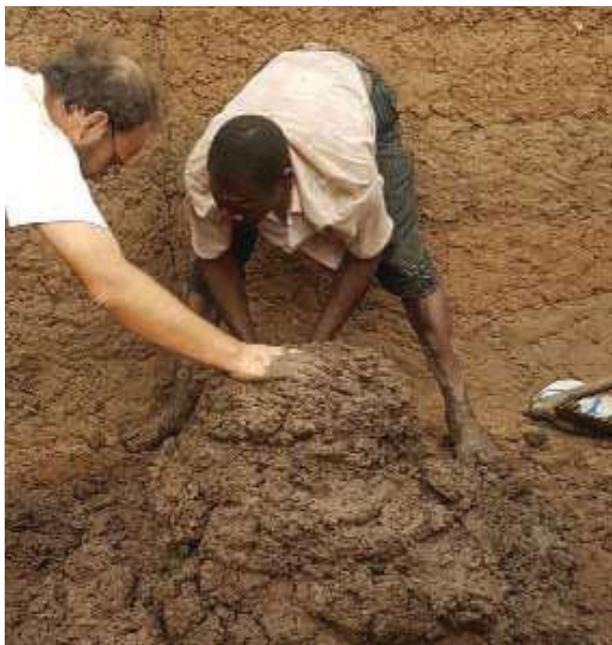
L'étape du mélange est significative dans la montée des murs; de la qualité du mélange dépendra la solidité du mur.
