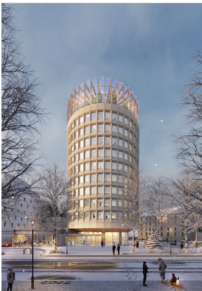
Photo : Racine @Maud Caubet Architectes
