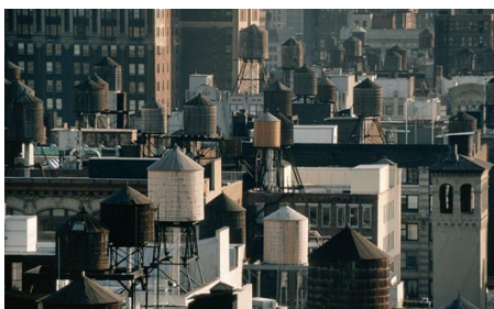
Figure 18 - Photo des cuves d'eaux pluviales. © Getty Images
