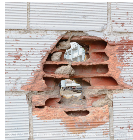
28/10/22 - Mur d'enceinte du DAV Ouest des Halles © Hugo Heller une lecture difficile du quartier depuis les Halles
