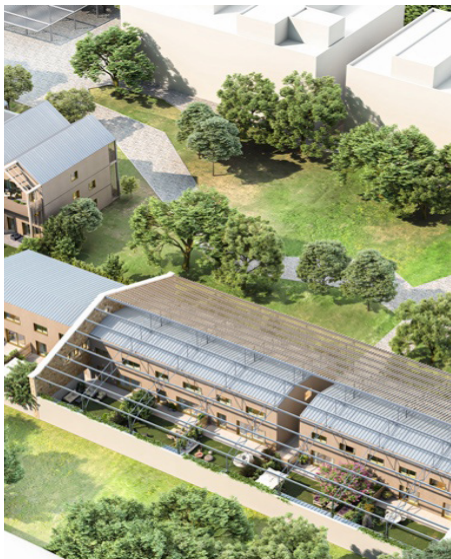
Projet The Camp par Mille Architectes au sein de la ZAC de Lorette à Saint Malo (chantier en cours)
