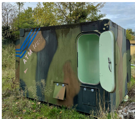
© La Ruche - Figure n°5 - ATM (abri technique mobile) resté sur site - 28/10/22
