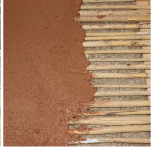
Enduit terre sur lattis bambou
