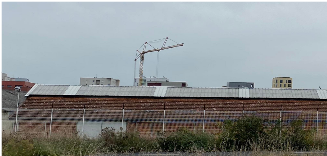
Figure 1 : Liens colorimétriques entre les Halles en briques et les constructions neuves, photographie prise par Aline Durand, 23 septembre 2022
