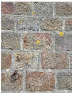
A Langan, village plus rural que la Chapelle-Chaussée, on retrouve davantage de constructions en bauge. La pierre de taille est également présente pour les soubassement et les chaînages pour protéger les angles. Le bâti contemporain est exclusivement en enduit crépi.
