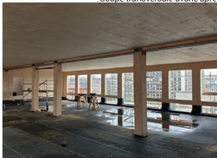
Vue de la structure en bois de la surélévation en chantier
