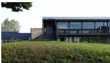
Cantine scolaire, Marçon, façade sud, septembre 2025
