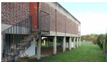
Cantine scolaire, Marçon, façade nord, septembre 2025
